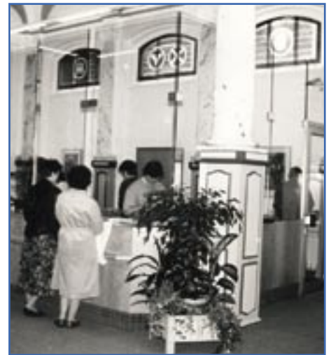
Schalterhalle in der Hauptstelle nach umfangreichen Sanierungsarbeiten 1990
