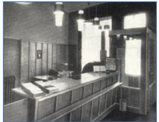
Schalterraum in der Zweigstelle Buckau
